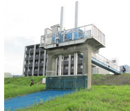
山王排水樋管 (写真:池内幸司)
